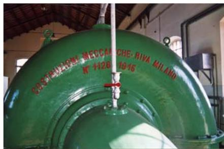
Le idrovore sono pompe usate per assorbire grandi quantità d'acqua risultanti da opere di bonifica. Una volta messe delle barriere al limite di un'area da bonificare, l'acqua viene convogliata in scoli e scoline dalle zone situate al di sotto del livello del mare. L'acqua viene poi pompata dalle idrovore verso collettori e canali di portata maggiore, situati ad un livello superiore a quello della zona circostante.
